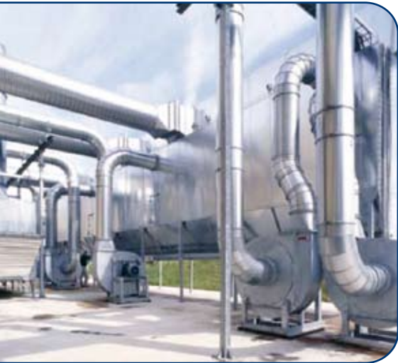
Erilliset puhaltimet mahdollistavat linjojen eriaikaisen käytön.
